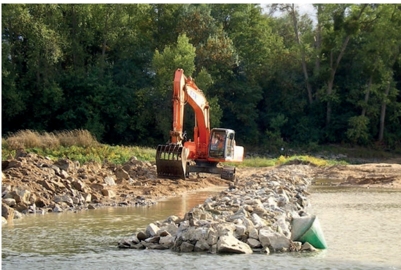
© VNF Remodelage des épis en 2009
