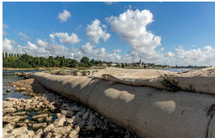
Boudins géotextiles des seuils du Fresne-sur-Loire
